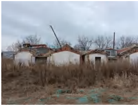
西南侧废弃房屋
