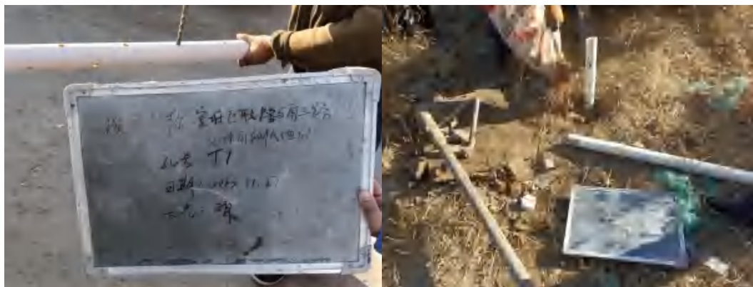
图 4-7 地下水监测井建井照片
