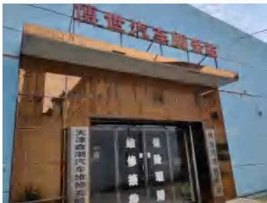
天津鑫潮汽车维修有限公司
